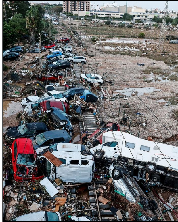
Şekil 50. Valencia Kentinde Sel Sonrası Hasar Gören Demir Yollarına Ait Bir Görüntü
